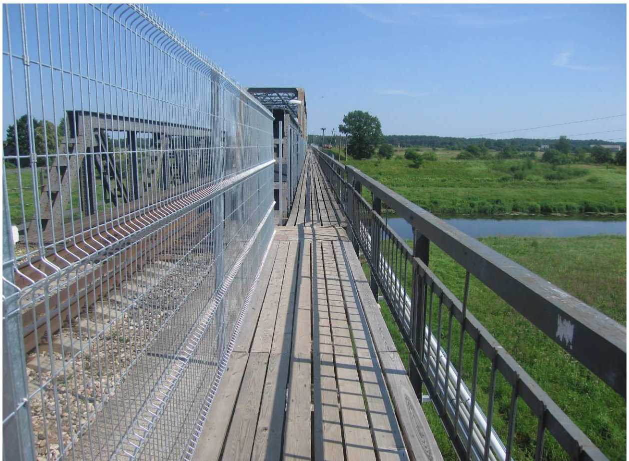
Pārejas tilts Jelgavā pirms rekonstrukcijas, 2009. gada maijs
