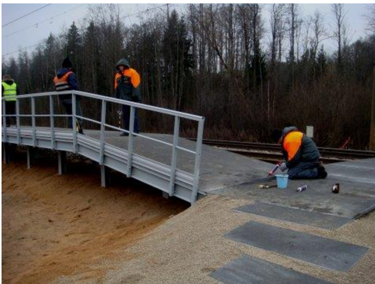
Perona konstrukcijas montāža bez vilcienu kustības pārtraukumiem
