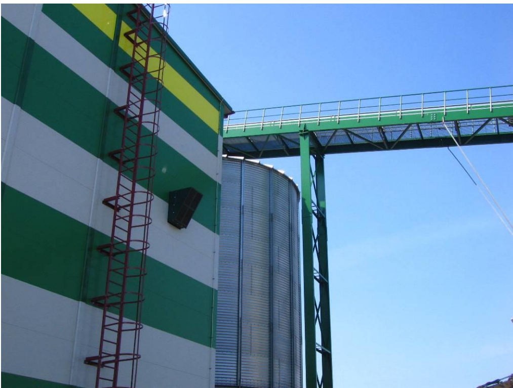
Ēkas fasādes apšuvums, trepes, galerijas
