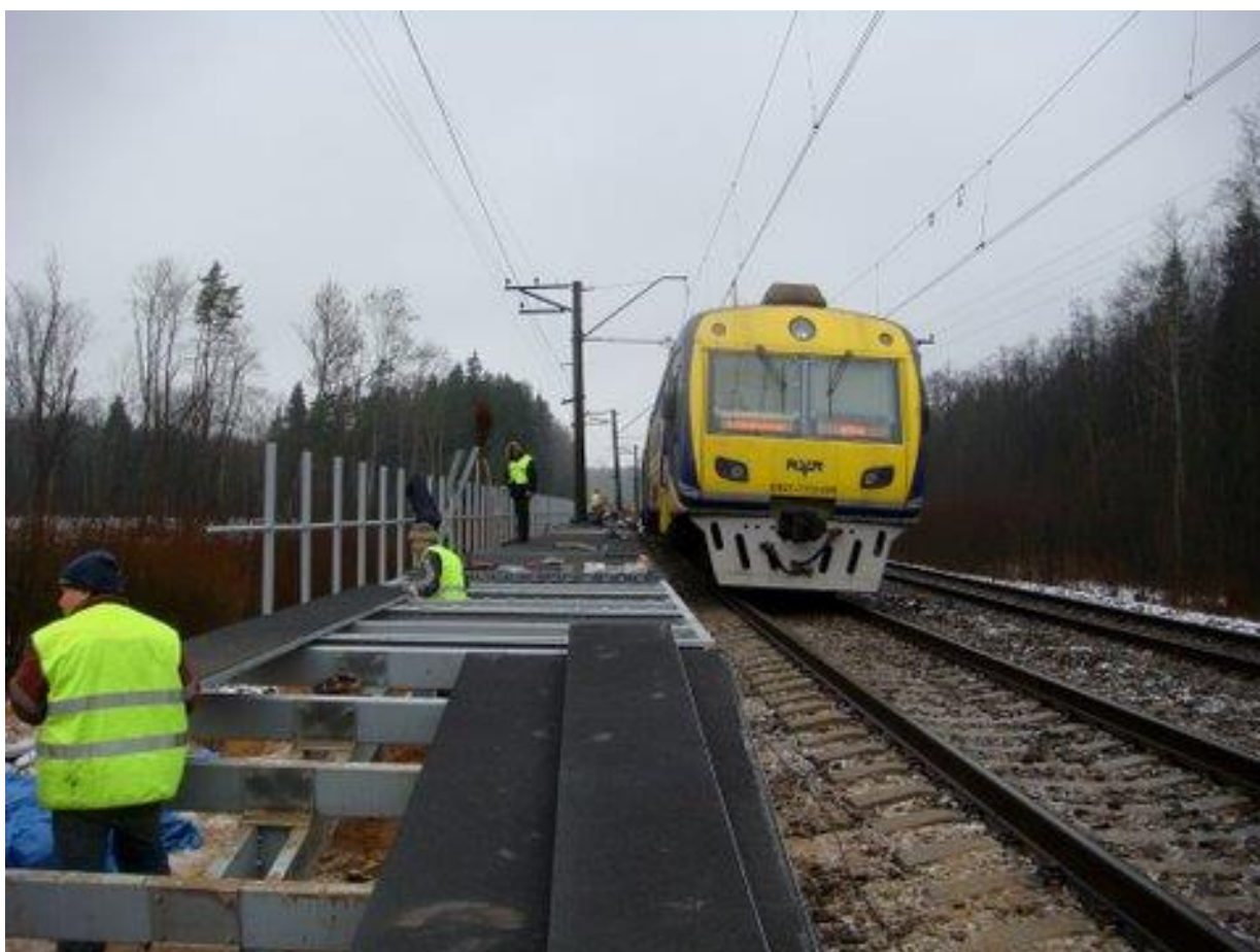
Perona konstrukcijas montāža bez vilcienu kustības pārtraukumiem
