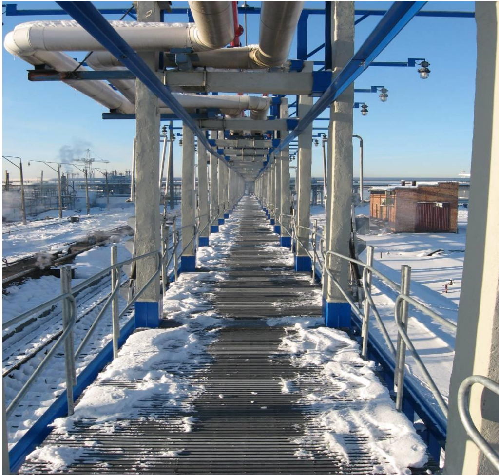
Dzelzceļa vagoncisternu izliešanas estakādes virszemes konstrukcija, Ventspils, 2009.gads
