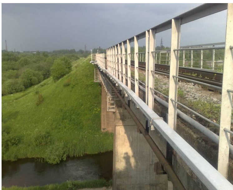
Nodrošina pilnu elektrokabeļa saglabāšanu – korozijas izturība. Dzelzceļa tilts, Krustpils, Latvija.
