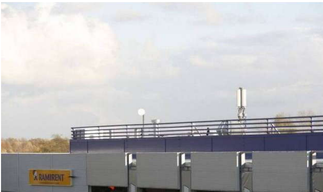
Konstruktijas uz jumta un jumtu nožogojumi.
