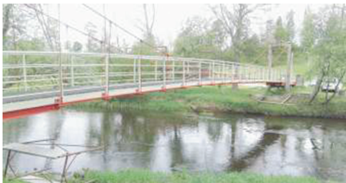
Iekārts gājēju tilts, garums 50 m
