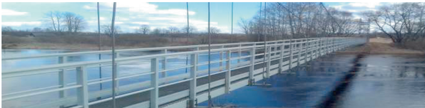
Tilts ar betona balstiem, atsaitēm un metāla konstrukciju Gājēju daļa un nožogojums no stikla šķiedras kompozīta
