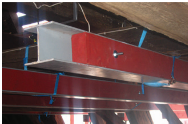
Atbalsta sija jumta konstrukcijās
