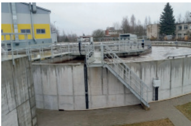
Notekūdeņu attīrīšanas iekārtas kāpnes un platforma
