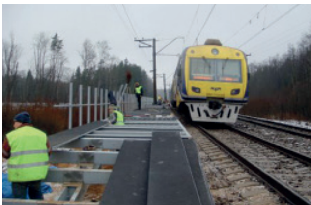
Dzelzceļa stacijas "Dendrārijs" būvniecība
