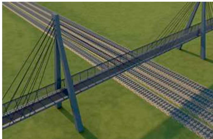
**Стекловолоконный мост с композитными опорами и стальными вантами**
