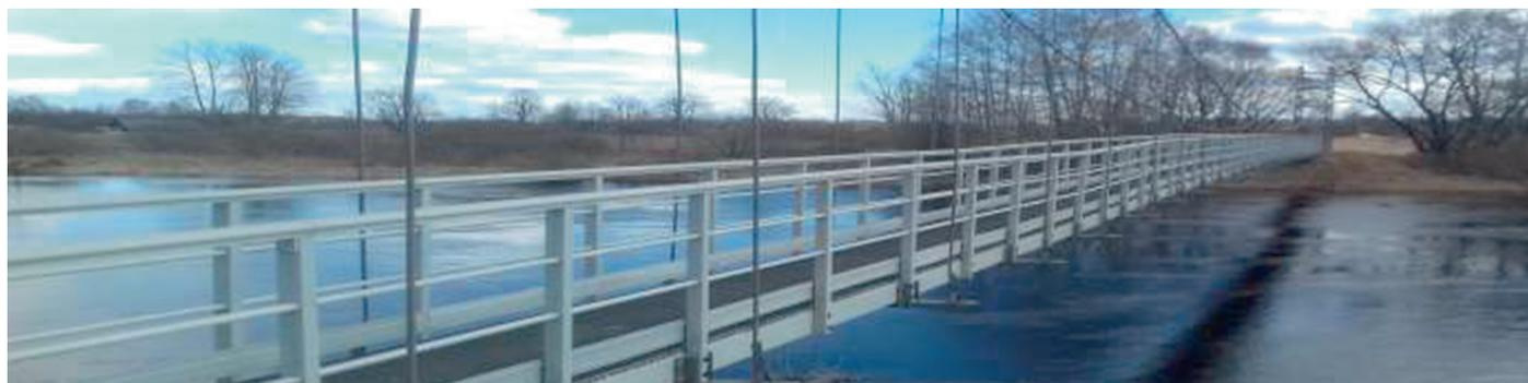
**Мост на бетонных опорах, с оттяжками и с металлической конструкцией**
