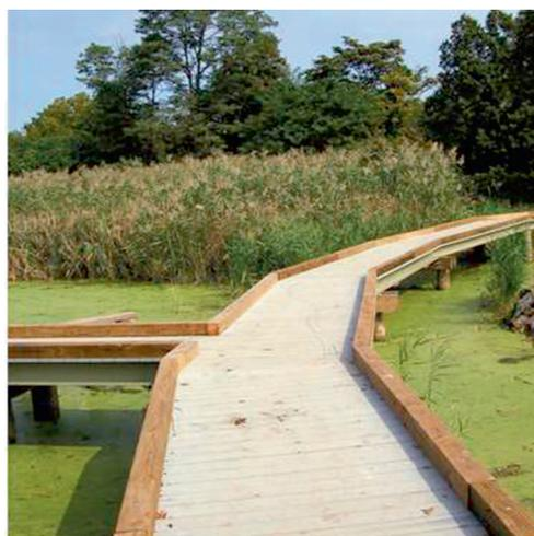
Пешеходные и велосипедные мосты в болотистых и в тяжело проходимых местах. Пристани для рыбалки, пристани на берегах озер и рек. Есть возможность строительства пристани с ограждением. Пристани устанавливаются на винтовые или композитные сваи. Необходимое основание зависит от спецификации грунта.
