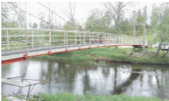
Подвесной пешеходный мост, длина 50 м
