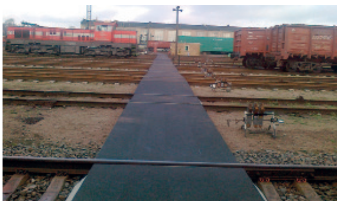
Переходы с противоскользящим покрытием через ж/д пути
