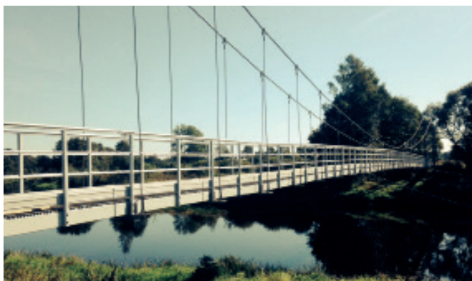
Подвесной пешеходный мост, длина 72 м
