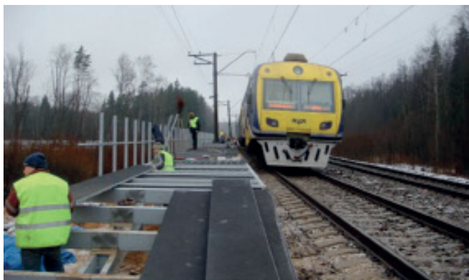
Строительство ж/д перрона, ст. Дендрарий
