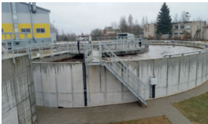
Конструкции лестницы и платформы на очистных сооружениях
