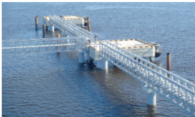
Техпричал для обслуживания судов, пролет 24 м
