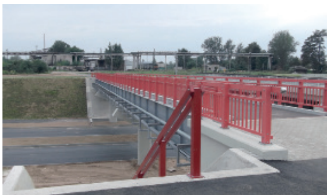
Пешеходный мост (композитные плиты, перила)
