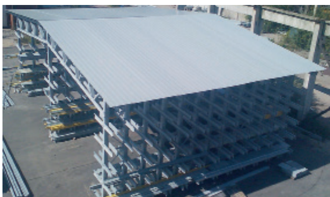
Ангар - конструкция склада
