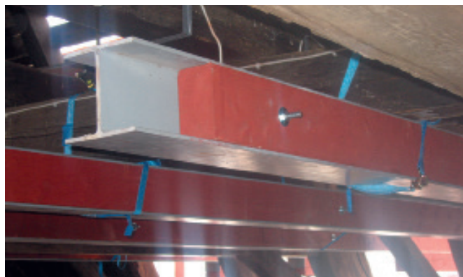
Усиление балки перекрытия
