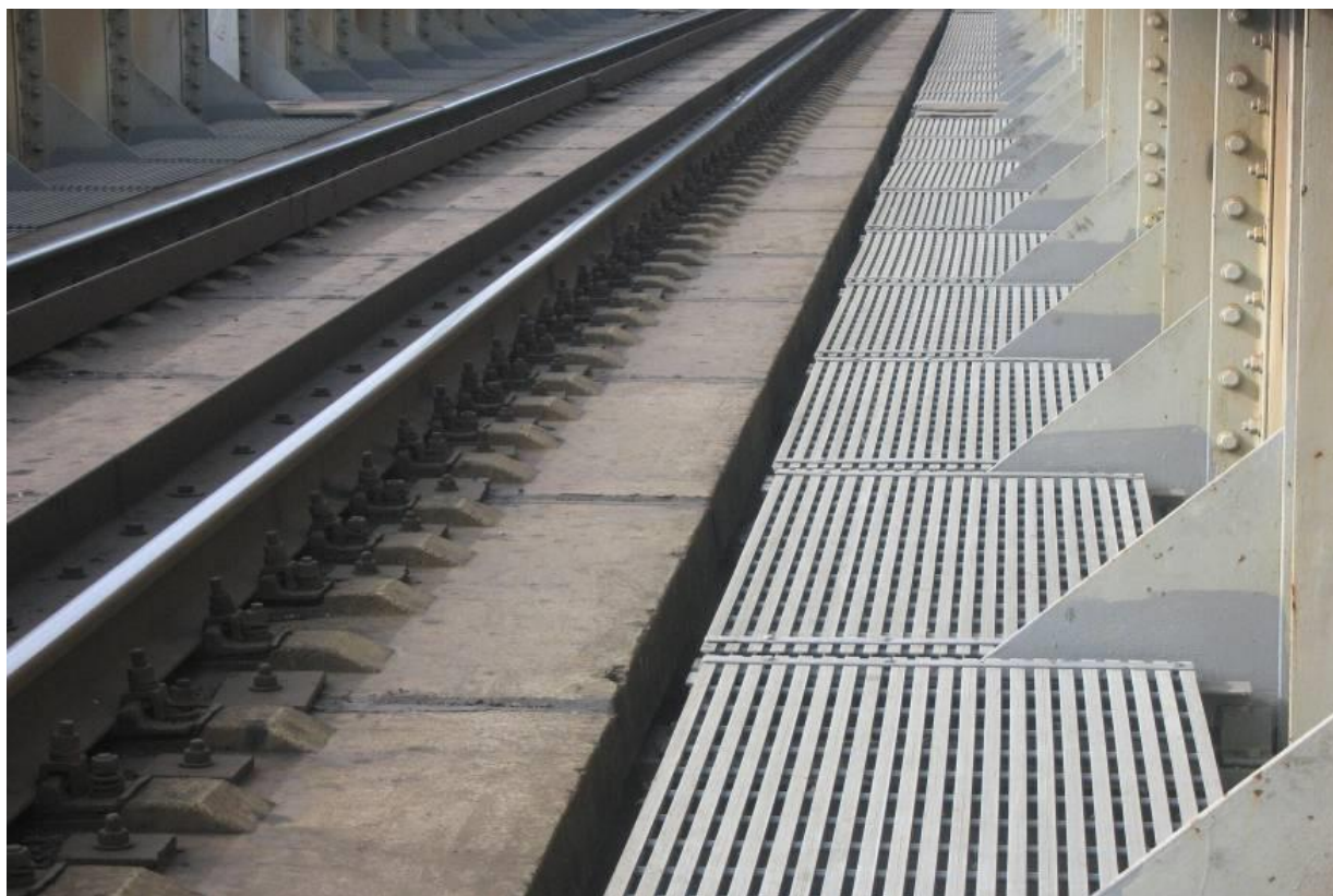
Железнодорожный мост в г.Огре
