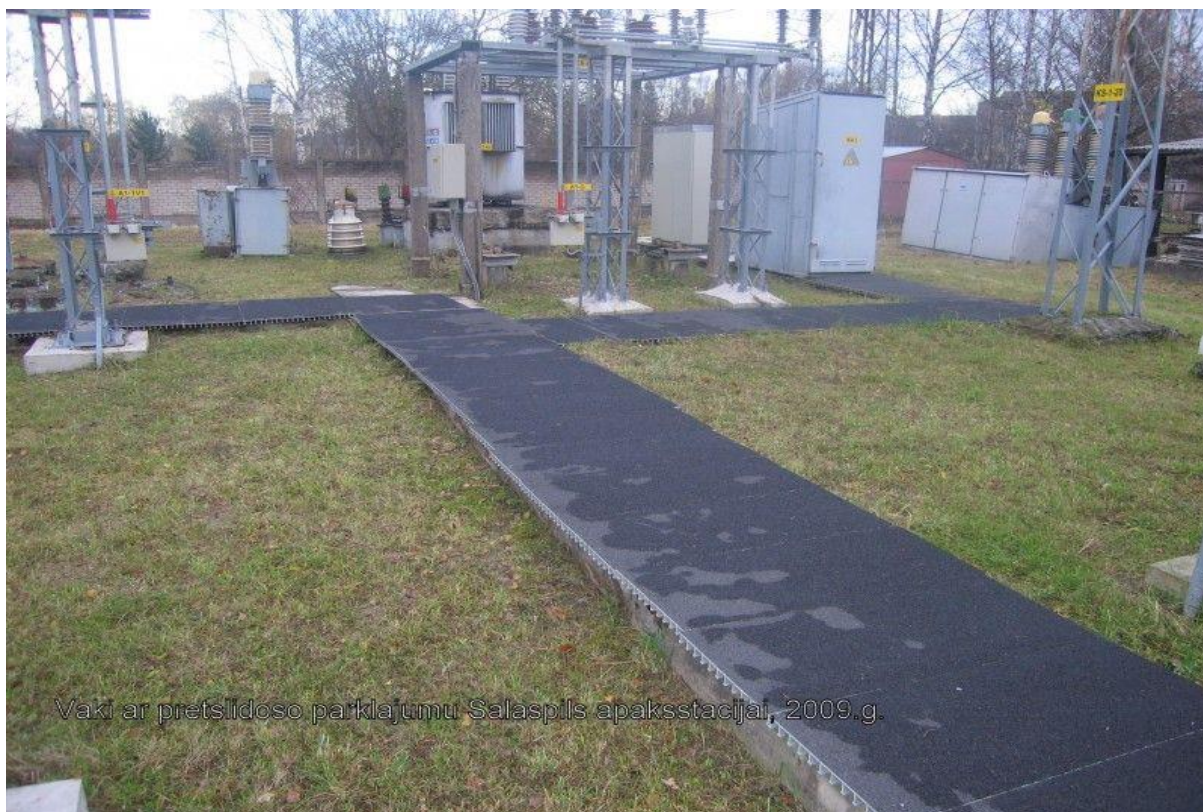
Крышки из стекловолоконного композита после реконструкции
