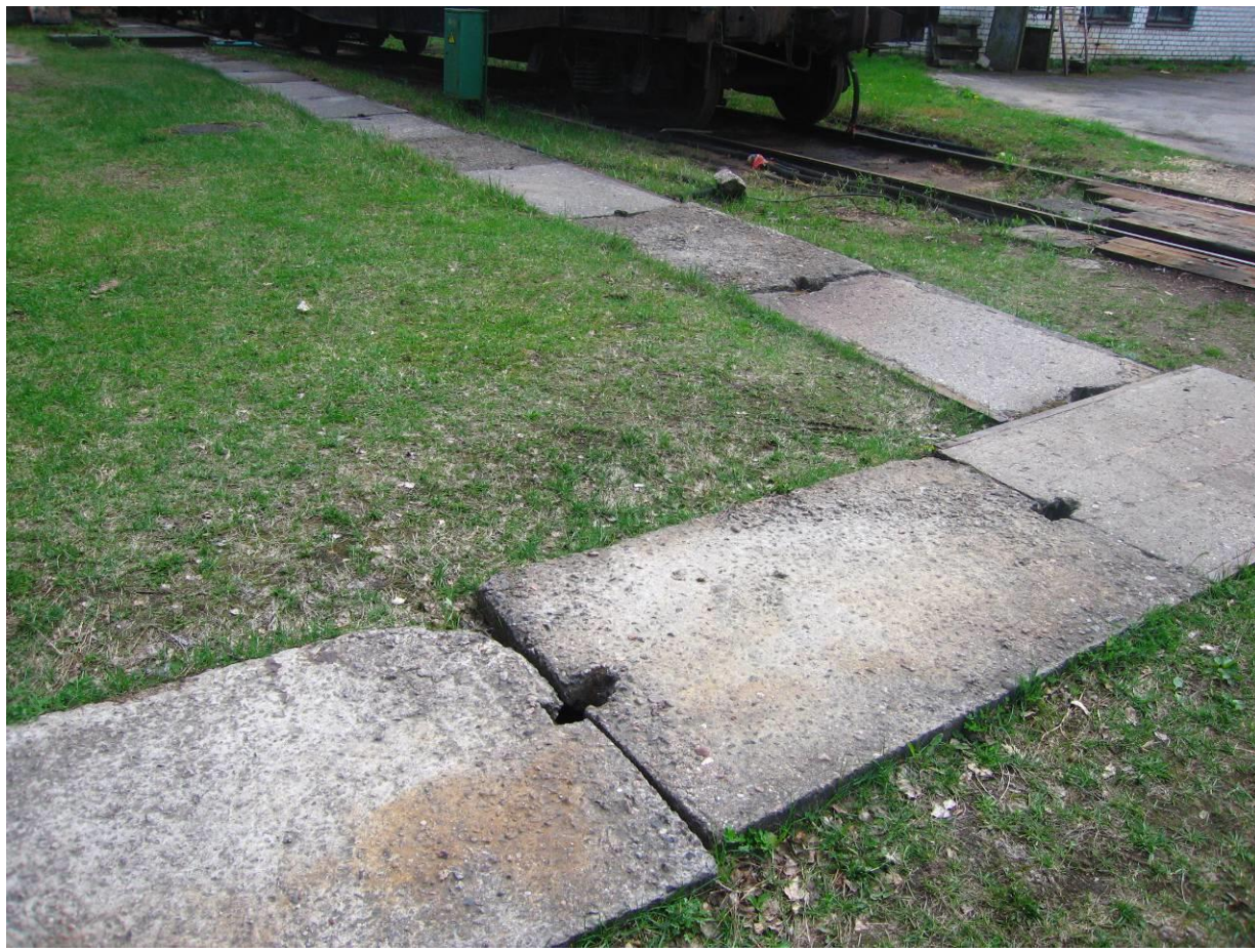
Крышки из бетона до реконструкции
