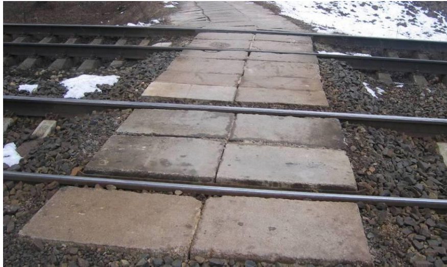
Железнодорожный переход из бетона до реконструкции
