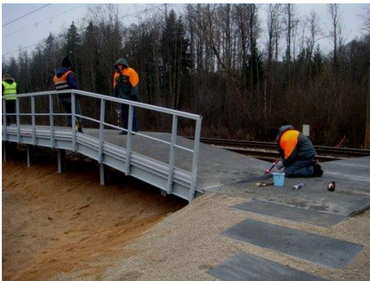
Монтаж конструкции перрона без остановки движения поездов
