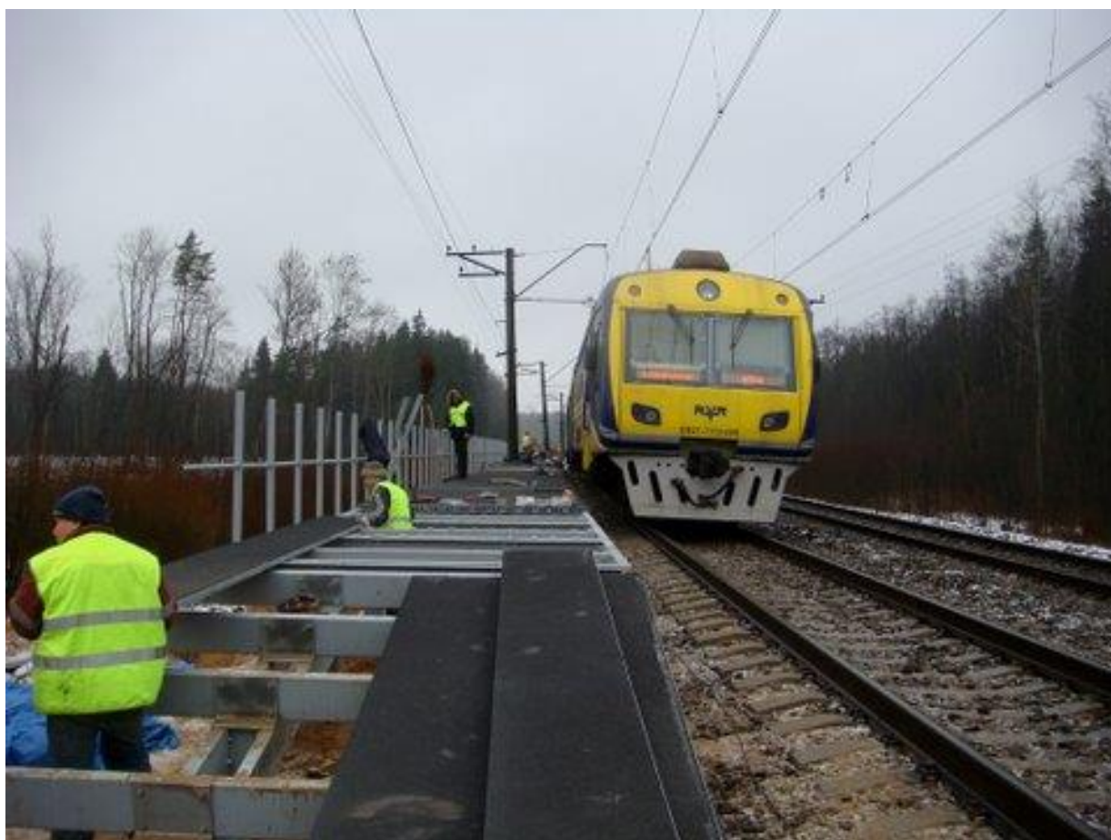
Монтаж конструкции перрона без остановки движения поездов
