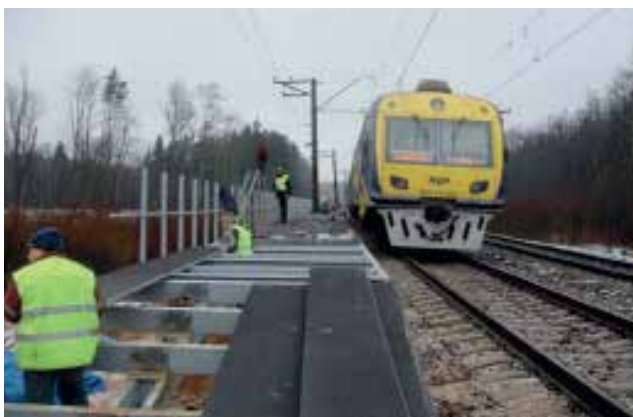
Dzelzceļa stacijas "Dendrārijs" būvniecība
