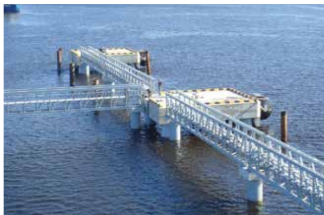
Kuģu apkalpošanas tilts, 24 m katrs posms
