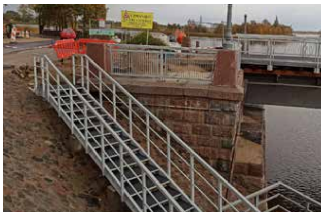
Liepājas tilts, kāpņu konstrukcija
