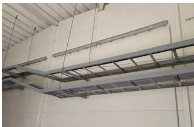
Balticovo, kabelplauktu sistēma
