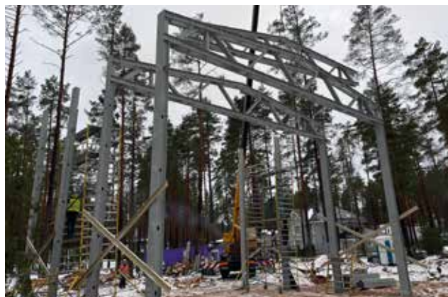
Angāru konstrukcijas būvniecība
