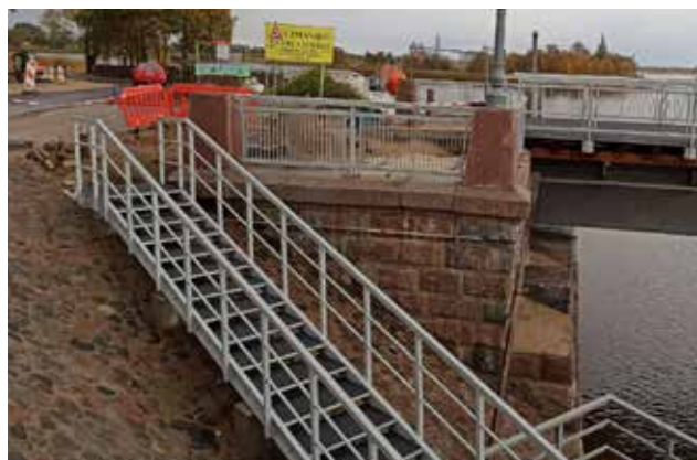
Liepājas tilts, kāpņu konstrukcija
