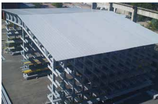
Angārs – noliktavas konstrukcija
