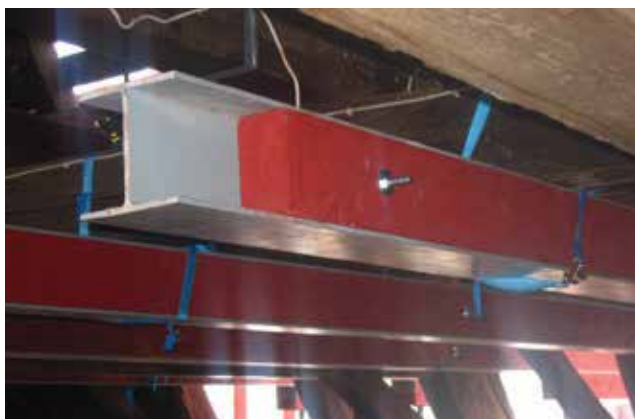
Atbalsta sija jumta konstrukcijās
