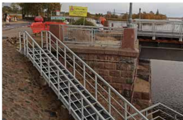
Liepājas tilts, kāpņu konstrukcija
