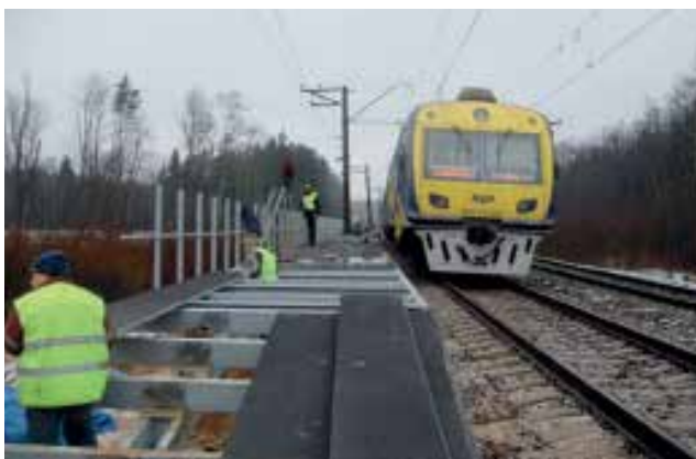
Dzelzceļa stacijas "Dendrārijs" būvniecība
