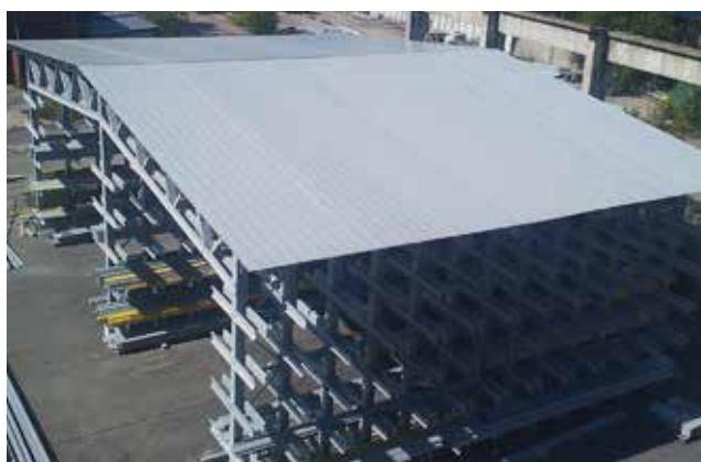
Angārs – noliktavas konstrukcija
