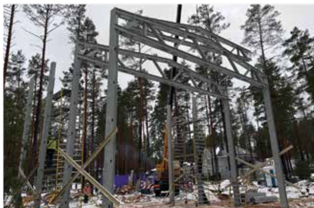
Angāru konstrukcijas būvniecība
