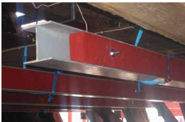
Atbalsta sija jumta konstrukcijās
